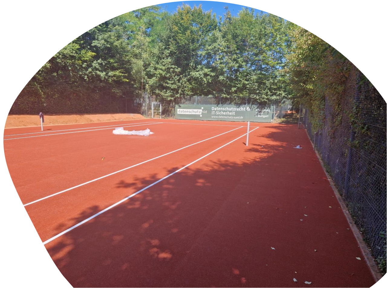
Auf dem vollständig beklebten Platz wurden die Linien aufgebracht. 2-Komponenten-Material. Die Linien haben die gleiche Höhe wie der eingestreute Platz.
