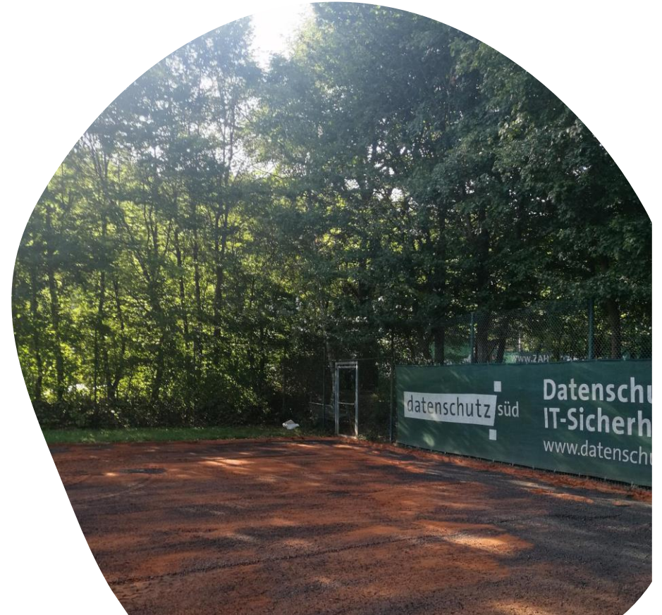
Die darunter befindliche dynamische Schicht (Lava) muss ggfs. soweit abgetragen werden, dass sie wieder richtig wasserdurchlässig ist.
