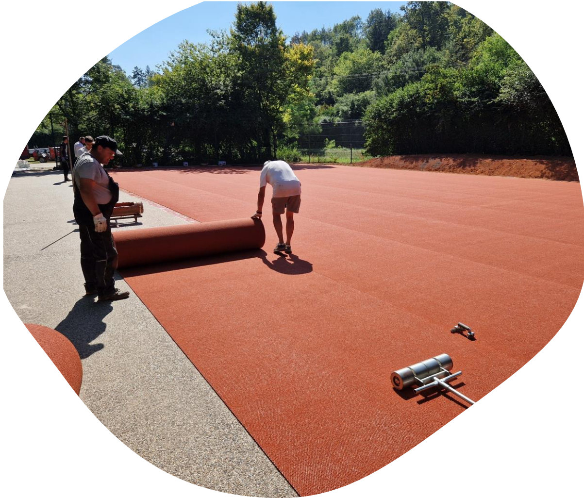
Die Membrane wird verklebt.
